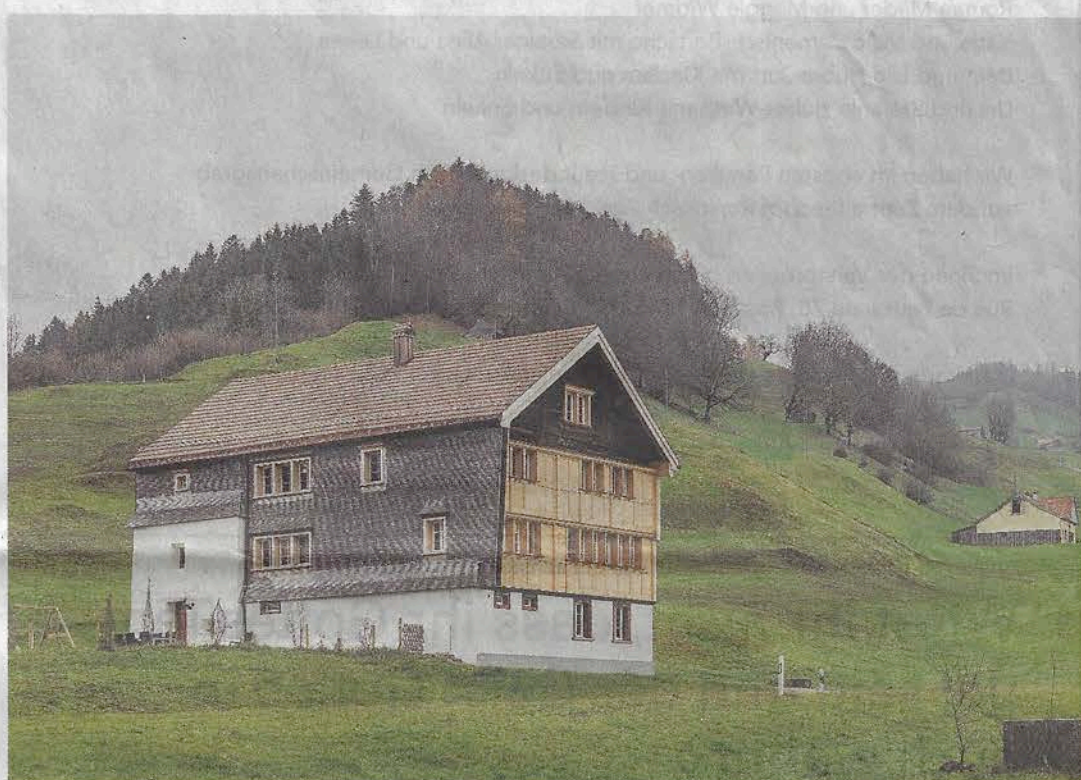
An der Südfassade des Zithus war einst eine Sonnenuhr angebracht.
